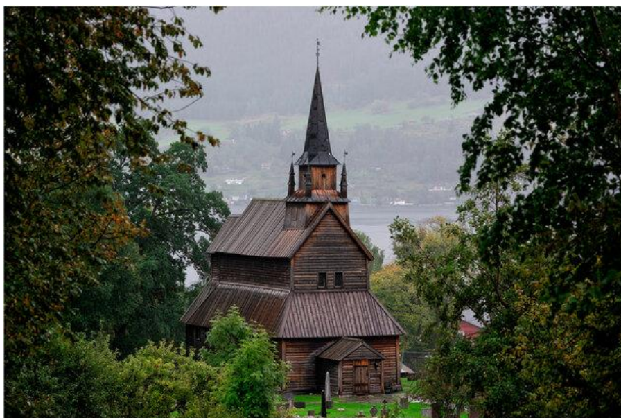
Slika 1.1. Kaupanger stave church u Norveškoj [1]
