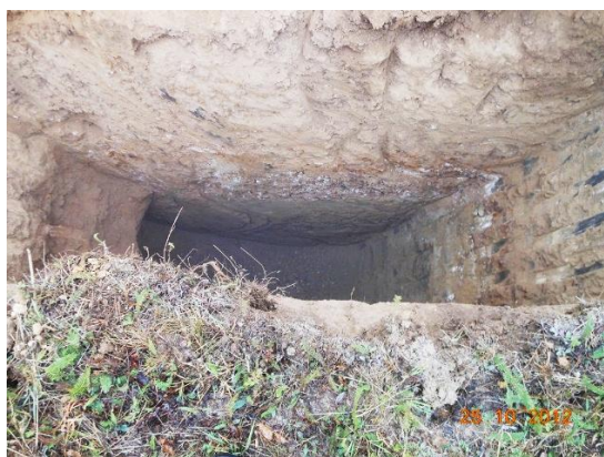
Слика 3. Типичан изглед сондажне јаме дубине 3-4м
