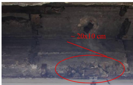
Slika 5. POS.FG 204 – presečena armatura u donjoj zoni prilikom ugradnje bravarskih elemenata između osa G-F-E
