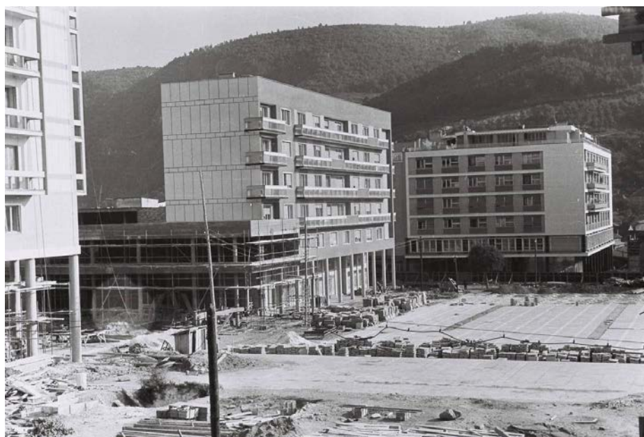
Слика 07. Блок током изградње (1961) Figure 07 – The Block during construction (1961)
