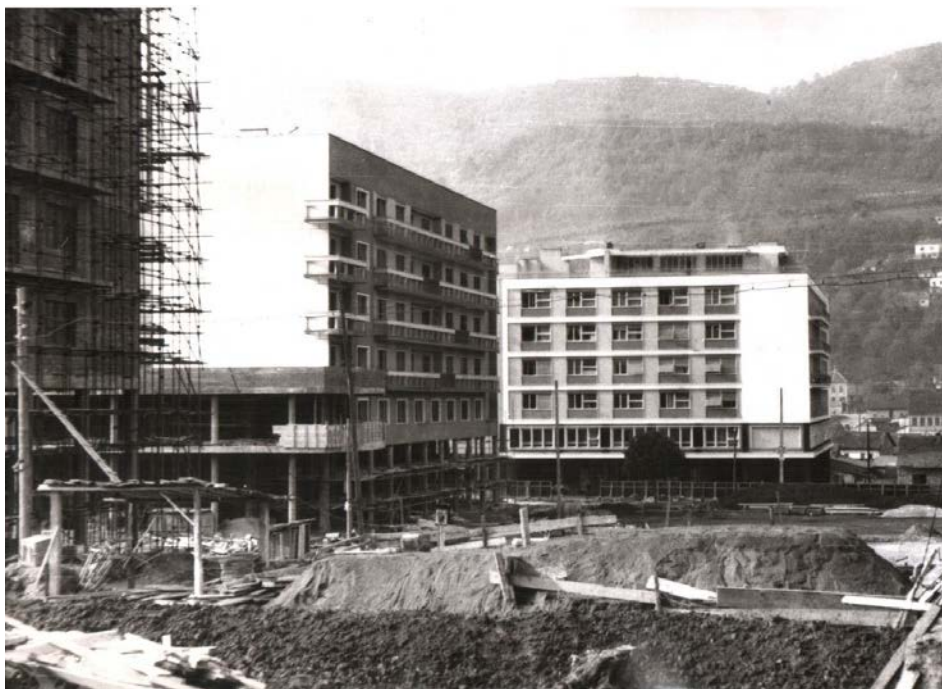
Слика 06. Блок током изградње (1961) Figure 06 – The Block during construction (1961)
