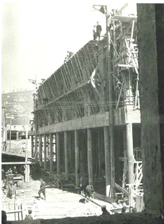
Слика 05. Блок током изградње (1959) Figure 05 – The Block during construction (1959)
