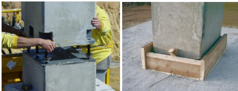
Slika 6a. i 6b. Faza montaže stubova i podlivanja veze
