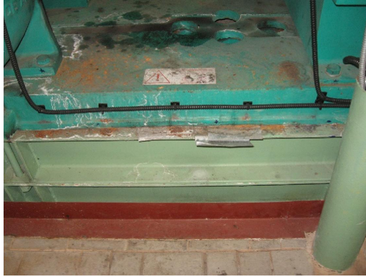
Slika 5. Detalj sanacije crpnog agregata
