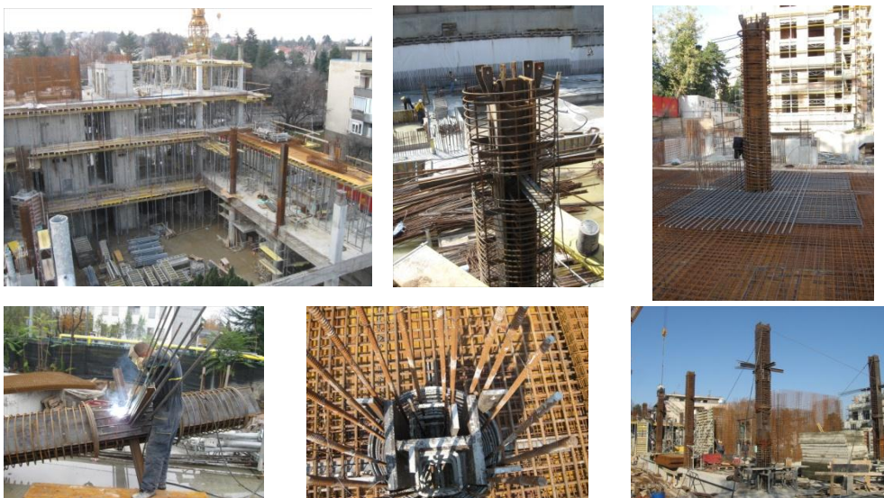
Slika 7 – Izvođenje spregnutih stubova sa krutim čeličnim profilima
