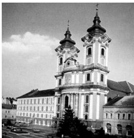
Sl. 34 – Centralni trg kojim dominira crkva, Eger, Mađarska
